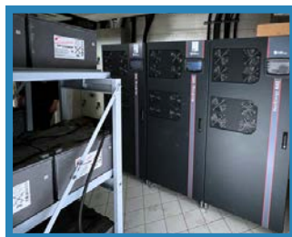
Medizinisches Labor 3 x 250kVA USV-System
