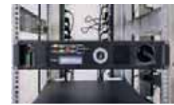
Modul festschrauben, nach dem Anlaufen manuellen Bypass zurücksetzen.
