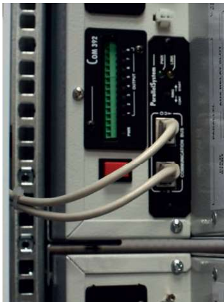
Parallelkonfiguration und programmierbare Relaiskarte
